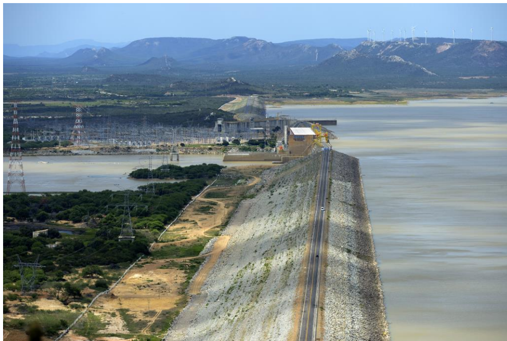
Figura 020 – Barragem de Sobradinho em 2022.
